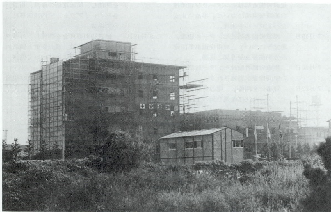
竣工間近の建産連会館遠景
