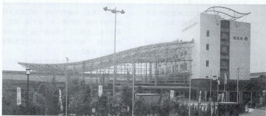
川口緑化センター・道の駅あんぎょう樹里安
