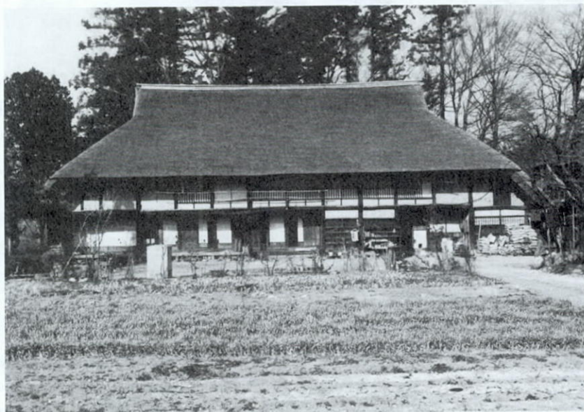
重要文化財 秩父市 内田家住宅
