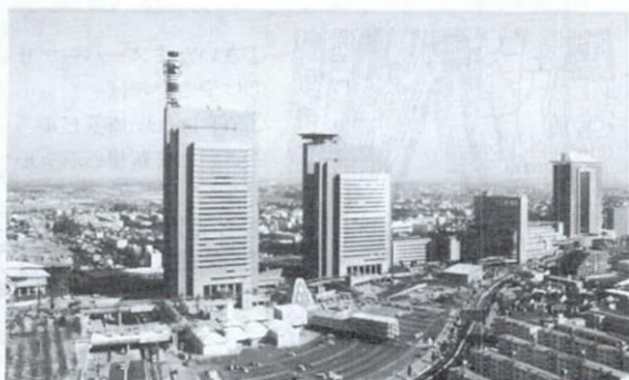
左から1号館、2号館、右端が郵政庁舎
