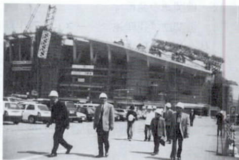
県営サッカースタジアム建設現場の視察
