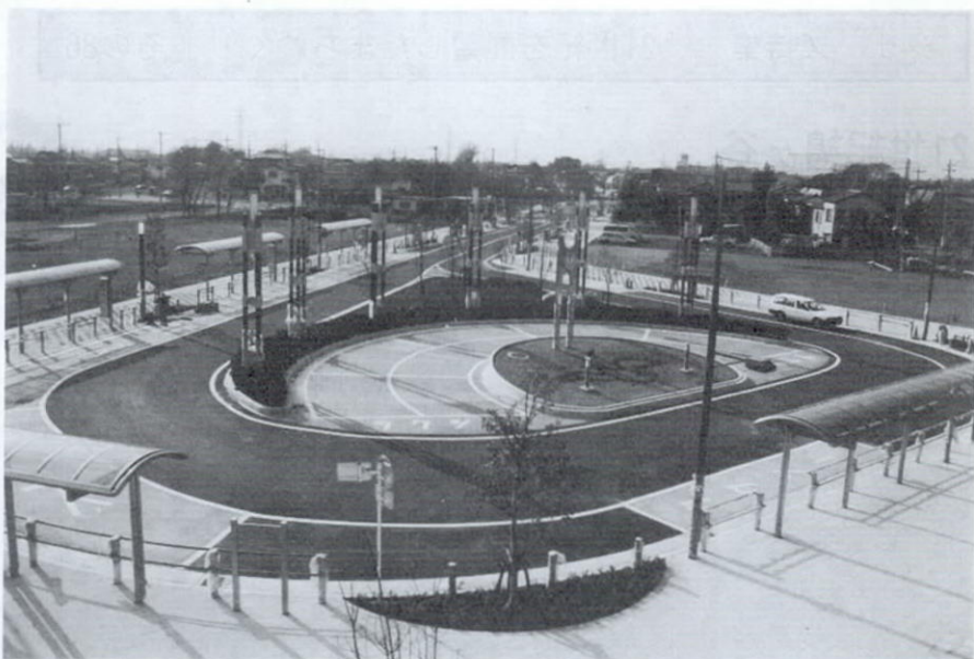
区画整理が進む鳩ヶ谷駅西口駅前広場
