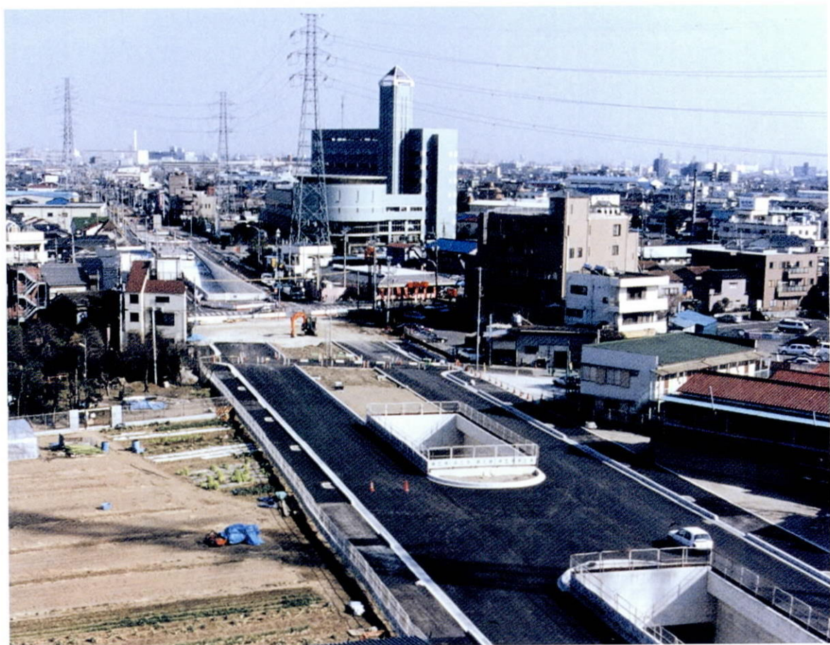
完成間近の第2産業道路と鳩ヶ谷市庁舎周辺 鳩ヶ谷市提供
