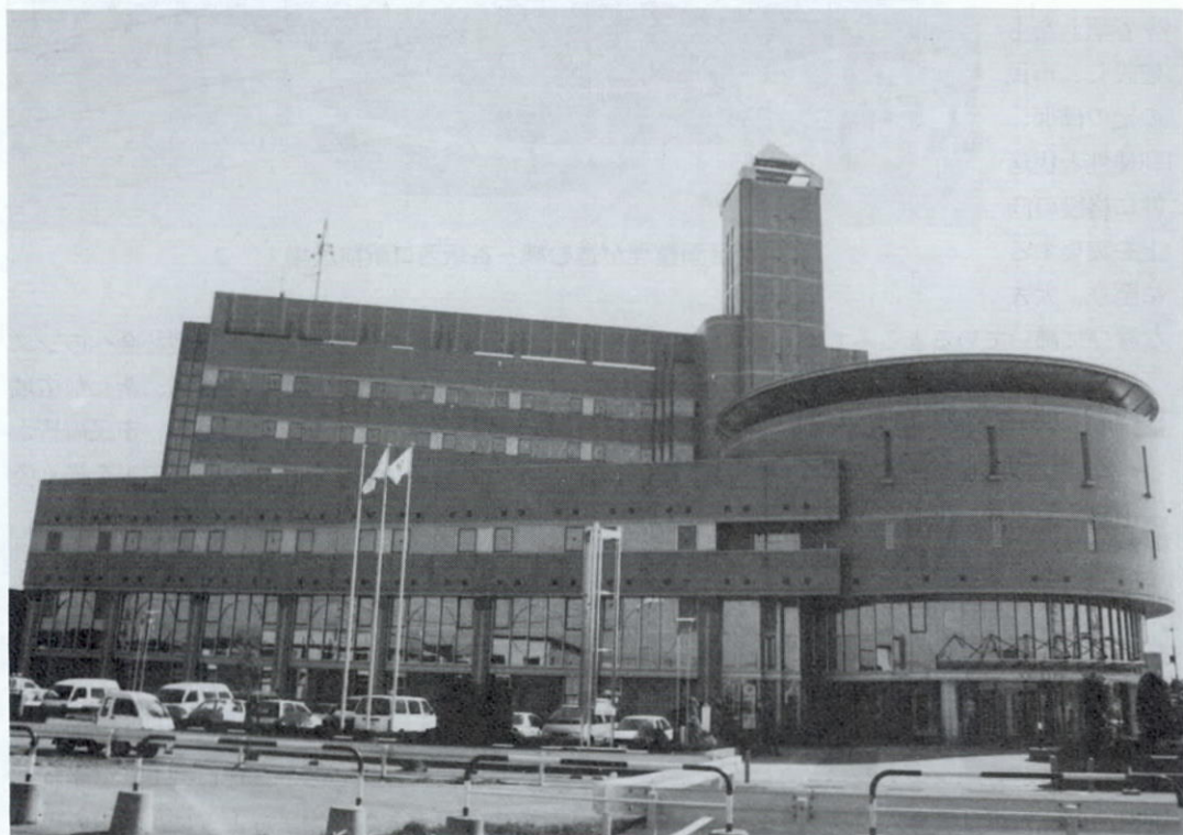
鳩ヶ谷市庁舎
