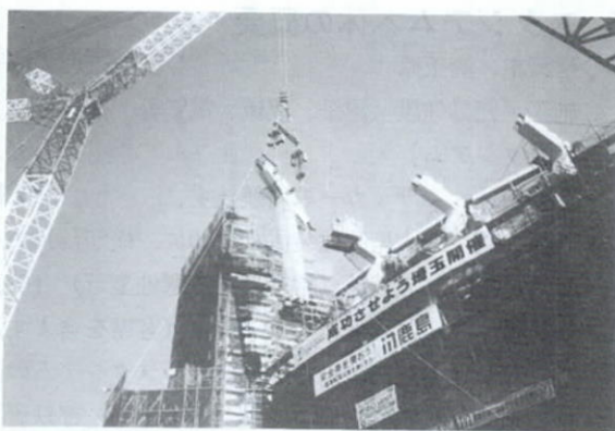
大型クレーンで部材を吊り上げ
