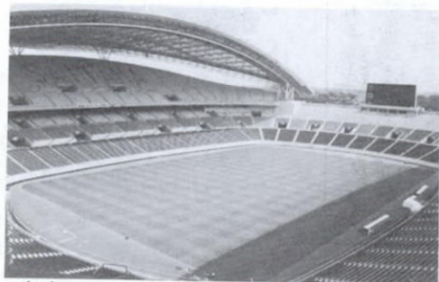
完成し一般公開された埼玉スタジアム2002 (埼玉県スタジアム建設局提供)
