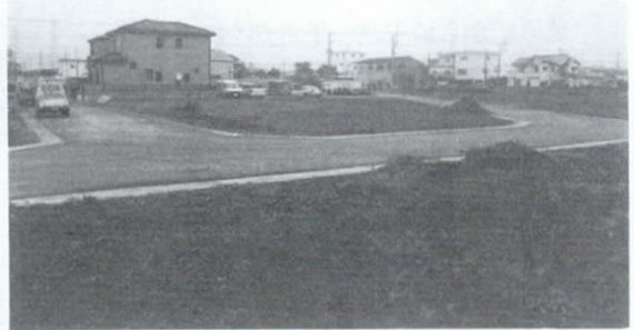
八潮南部地区整備状況
