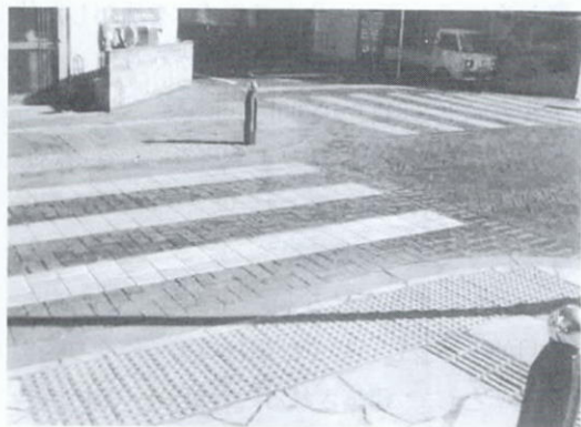
写真4 歩道と車道の段差がほとんどない道路
