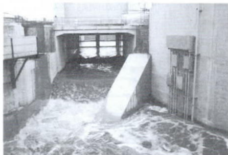
▲台風6号流入状況（第3立坑・倉松川側）（H14.7.10）
