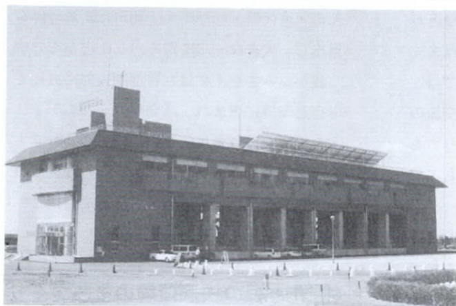
首都圏外郭放水路排水機場
