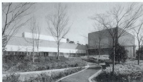
通信・放送機構 本庄情報通信研究開発支援センター
