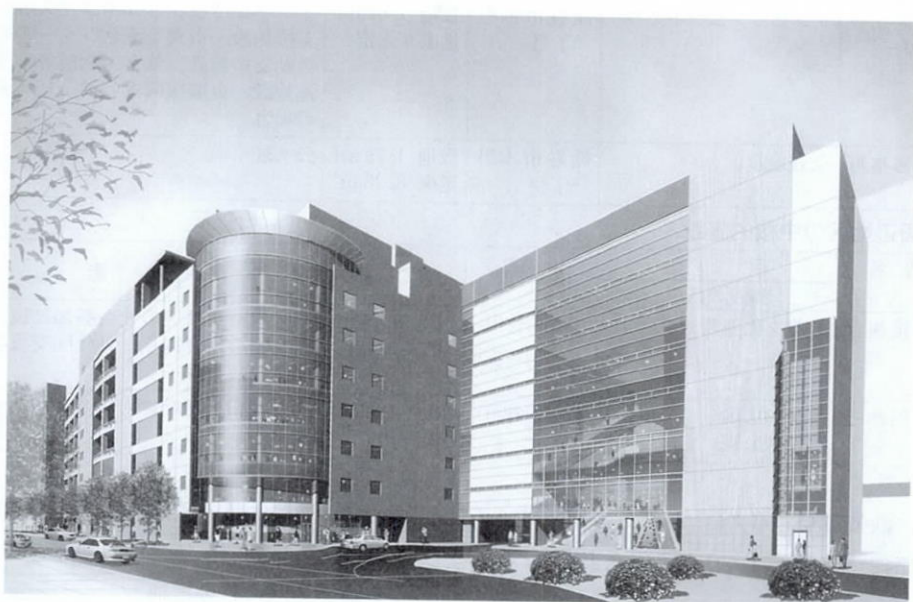
熊谷駅周辺地区における中核的施設として平成16年中の開業を目指して建設が進む「熊谷駅東地区再開発ビル」
