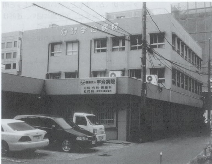
大宮区宮町の県道沿いに建つ宇治病院
