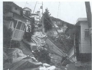
■阪神・淡路大震災による被災状況
