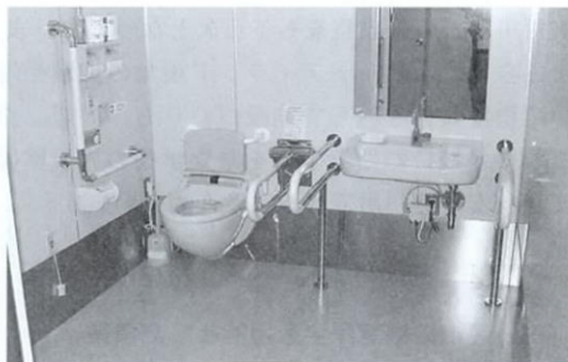
車いす使用者用トイレ
