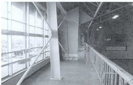
体育館補強ブレース
