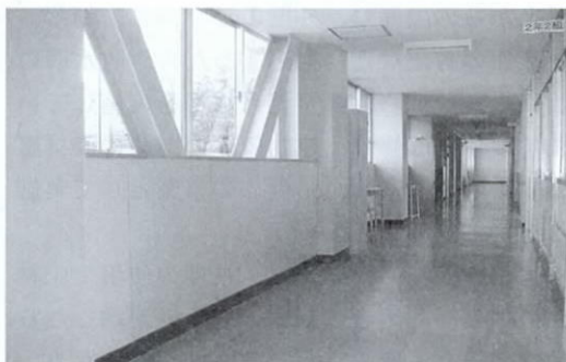
教室棟補強ブレース
