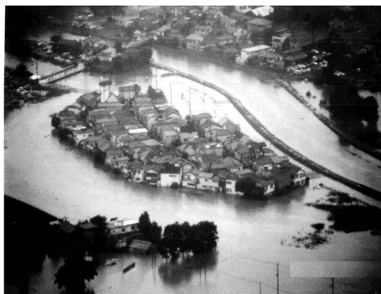
平成10年9月台風5号による被害状況
