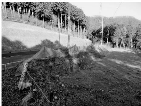
駐車場(整備前)
