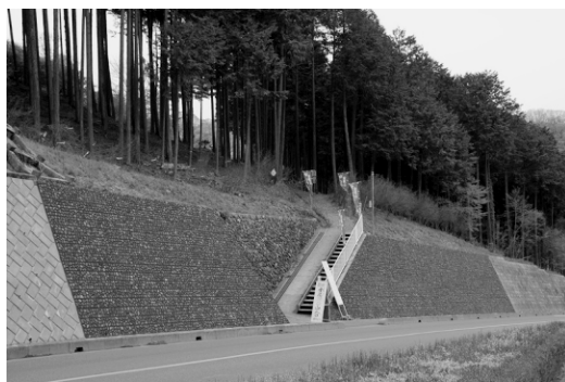
擁壁(ナチュロックによる改修)
