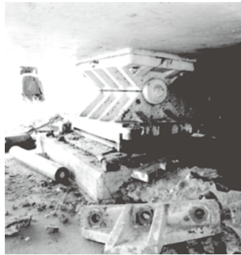
写真 3 :新潟県中越地震による橋梁の損傷事例 (国土技術政策総合研究所資料より)
