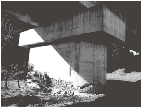
写真 3 :新潟県中越地震による橋梁の損傷事例 (国土技術政策総合研究所資料より)
