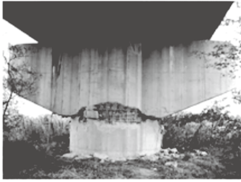
写真 3 :新潟県中越地震による橋梁の損傷事例 (国土技術政策総合研究所資料より)
