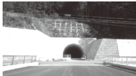
国道299号 飯能日高BP(坂石町分工区)
