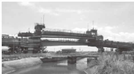
国道125号 行田BP（行田大橋）
