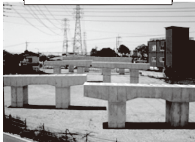
② 工事区間（橋りょう部）
