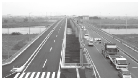
国道122号 昭和橋
