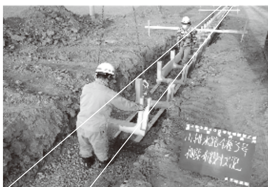
丁張を2本設置し通りと見栄えの向上
