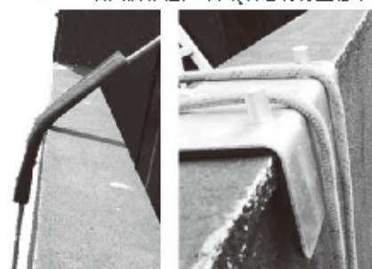
切断防止措置の例（口き型養生）▲
