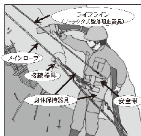
のりす保護工事でのロープ高所作業の例
