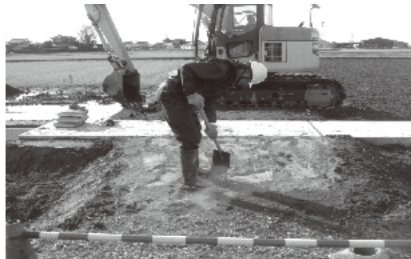
道路と横断 BOX との接続部に固化材を散布し、段差の発生を防止
