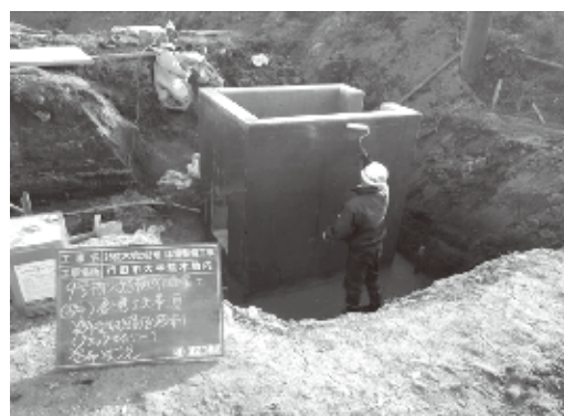
小型コンクリート構造物の品質確保 (ひび割れ防止剤使用)
