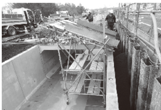
移動できる投入用シュートを工夫し、埋戻し作業等の着実で効率的な施工
