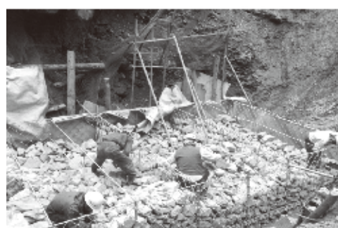
かご枠の周辺部から中央部へ、綺麗に、丁寧に石を並べる。下段から満杯に並べないと上段でかごが変形することあります。
