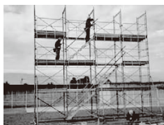
▲建設く体工事科 【取得可能な資格】 玉掛け技能講習 小型移動式クレーン 運転技能講習等
