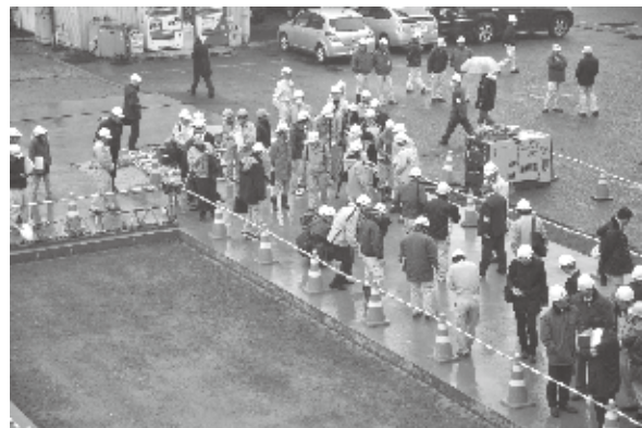
前日打設の施工状態を見学(11/11)
