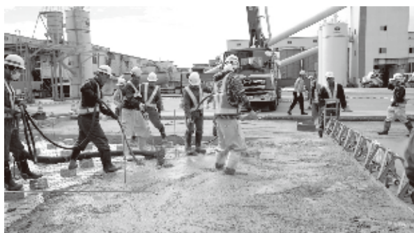
1DAY PAVEの施工状況 (11/10)
