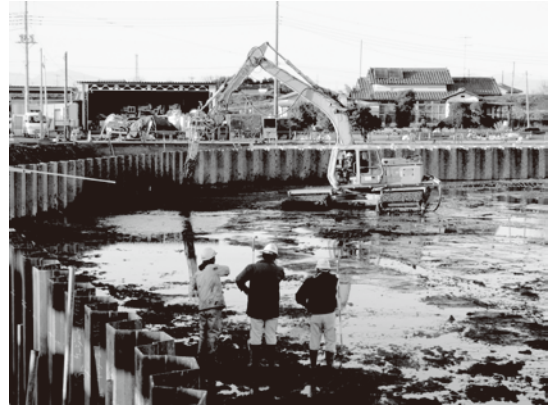
沼底安定のための沼土改良工。セメント固化材の配合変更など、発注者との協議・調整が必要
