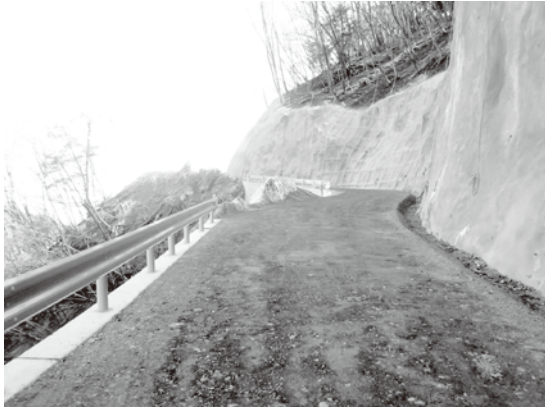
急峻な地形の中での森林管理道開設。斜面の微地形の変化や水の処理などで変更を余儀なくされることが多い
