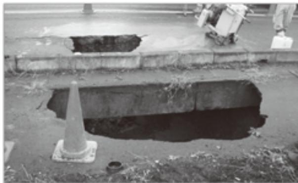
写真－1 道路陥没の発生事例(県道飯能寄居線)
