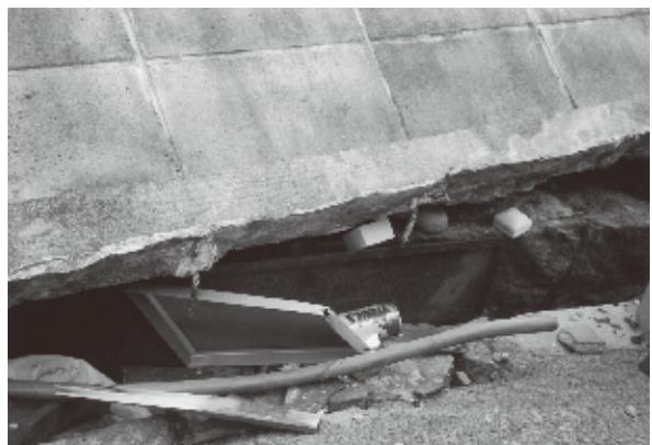
写真5 差し筋を用いたブロック塀の倒壊
