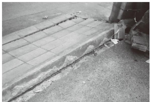
写真3 基礎の埋め込み深さが不足しており、基礎の根元から倒壊したブロック塀
