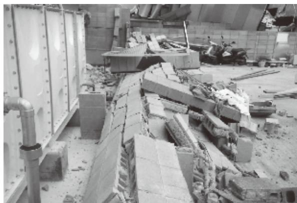
写真2 控え壁を設けているが、配筋量が少ないために倒壊したブロック塀
