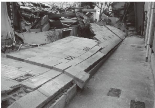
写真1 無筋のブロック塀の倒壊
