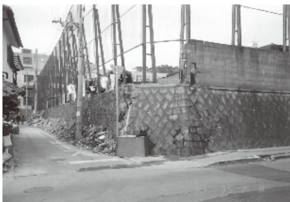
写真4 擁壁上に建設したブロック塀の倒壊
