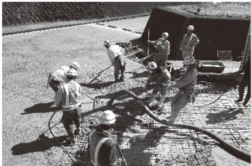
交差点部のポンプ圧送による打設状況
