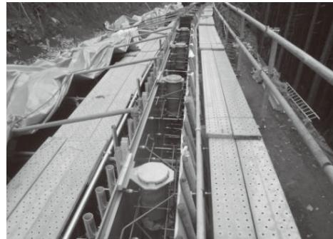
ボイド管を固定具に挟み込み型枠に固定
