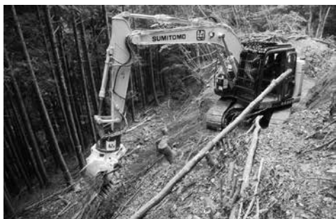
グラップルによる処理状況1
