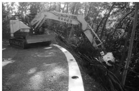
グラップルによる処理状況2
