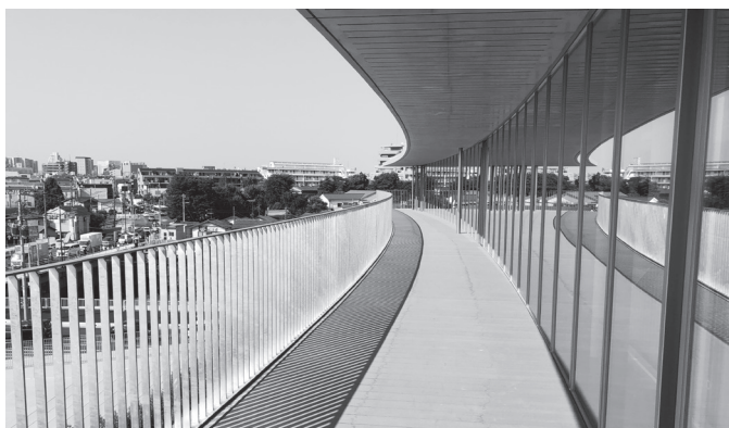
3階 庇を兼ねたテラスと南面ガラス窓
