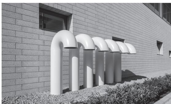
建物東側外周部に設置された地熱利用のための採熱パイプ
