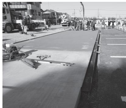
1DAY PAVEは、生コン工場で汎用的に用いられている材料で製造された高い強度レベルのコンクリートを、コンクリート舗装のセットフォーム工法又は土間コンの施工法に準じて舗設し、コンクリート打設後1日以内での交通開放を可能とした舗装です。
