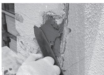
樹脂モルタル充填
