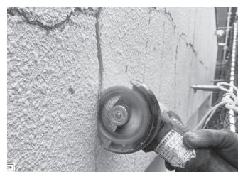
クラック部・Uカット処置
