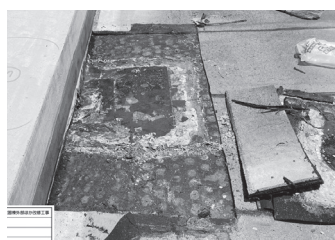
破損部を除去
