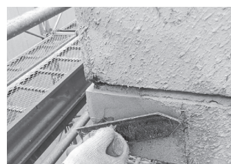
樹脂モルタル充填
