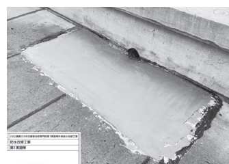
不陸調整・仮防水
