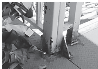
新規部材の溶接
