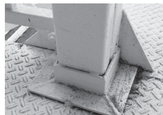
腐食部の取替・塗装完了
