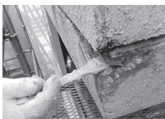
防錆プライマー塗布
