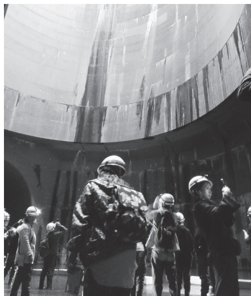
最大100m 3 /sの水が流れ込む流入口を 下から眺める
