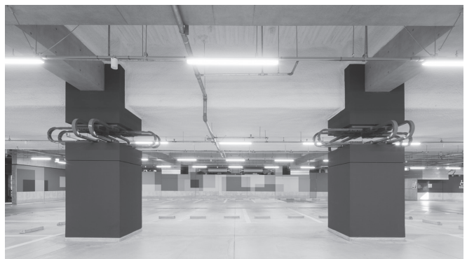
免震ダンパー（1階ピロティ駐車場）
