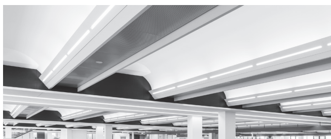
パンチングパネルを用いた空調吹き出し口
