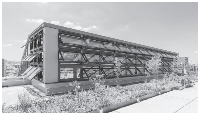
重力換気窓（シビック・キューポラ頂部）
